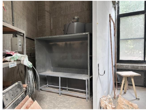
美術工坊安裝水洗台抽風機，用於施作粉塵排除，並完成整體空間之通風改善
