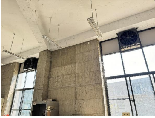
美術工坊安裝水洗台抽風機，用於施作粉塵排除，並完成整體空間之通風改善
